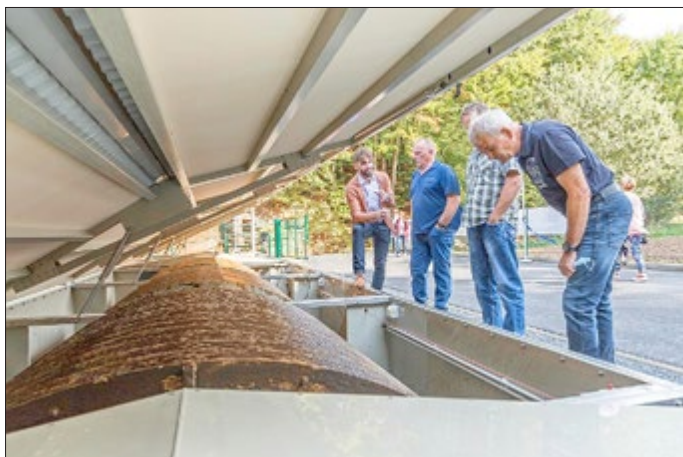
Marcus Heinemann (links), Fachbereichsleiter bei der EW Wasser, erläutert die Funktionsweise der Scheibentauchkörper der naturnahen Kläranlage Thalwenden.
