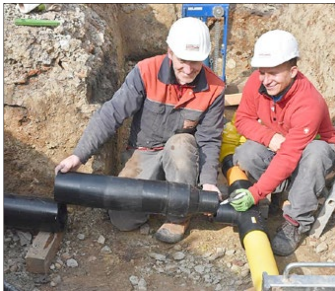
Martin Beyer (links) und Pascal Rönick von der Firma Elektrobau Bellinger aus Schönstedt binden Wendehausen von Katharinenberg aus an das Erdgas-Netz an. Foto: Reiner Schmalz
