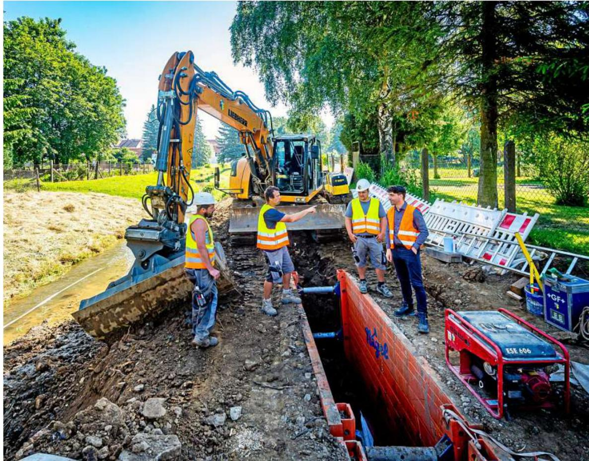
Entlang des Flusses Luhne (links) in Lengefeld wird gerade gebaut. Ein Kanalrohr soll das Pumpwerk zur Kläranlage Schildbach und den Verbindungssammler nach Bickenriede zusammenführen.
